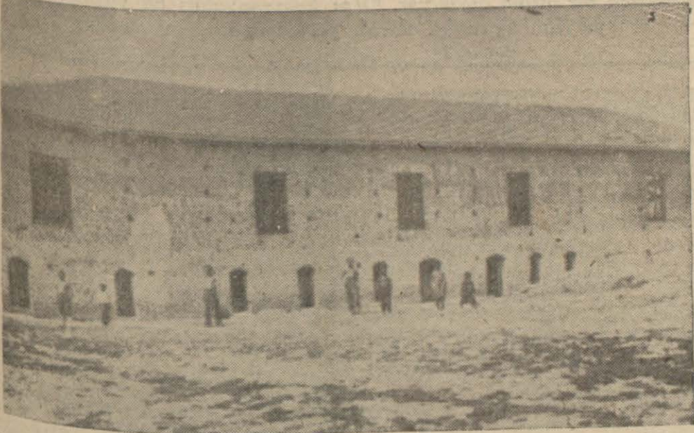
Kasaba köyü ilk mekteb binası
